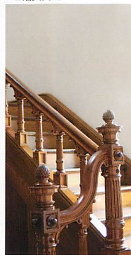
▲大階段手すり
