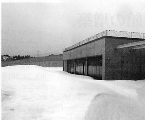
増築が予定されている体験工房南側の敷地
