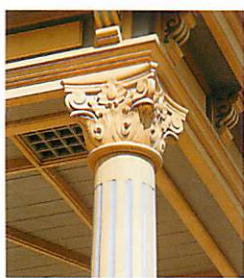
2階ベランダ柱頭飾 （CARVED ORNAMENTS ON THE COLUMN）
